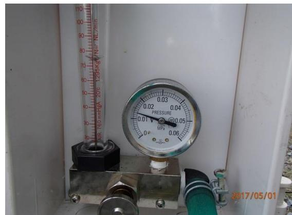
図6 目詰まり解消後 (風量及び圧力正常)
