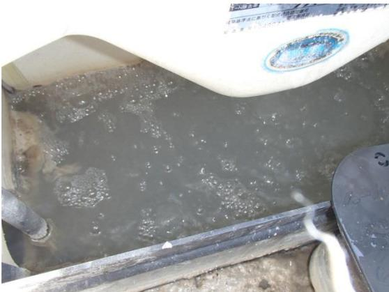
図3 散気管目詰まり (空気の吐出が弱い)
