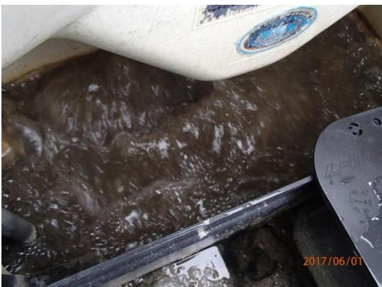
図5 目詰まり解消後 (空気の吐出が正常)
