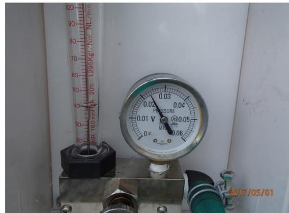
図4 散気管目詰まり (風量低く圧力高い)
