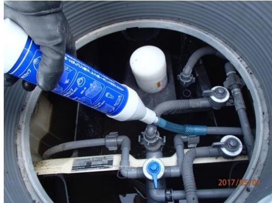
図2 真空式パイプクリーナーの使用状況
