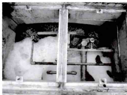
図-17 担体流動生物濾過槽
