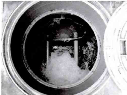
図-18 夾雑物除去槽
