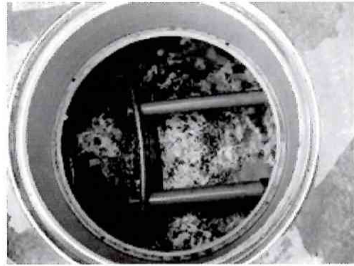
図-12 夾雑物除去槽
