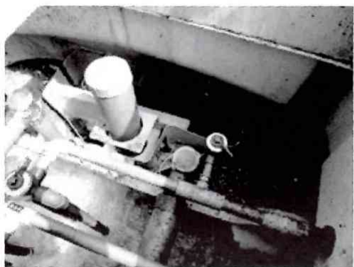
図-15 担体流動生物濾過槽
