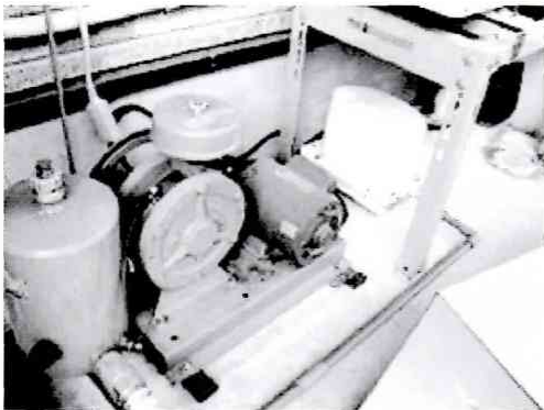
図-6 ブロワの状況
