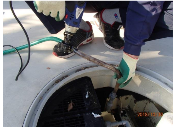
図5 ドリルポンプの使用状況
