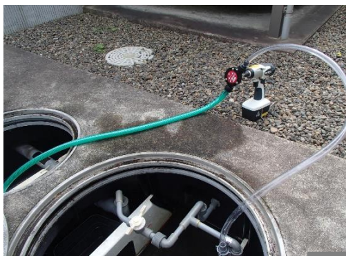
図 11 ドリルポンプの接続状況
